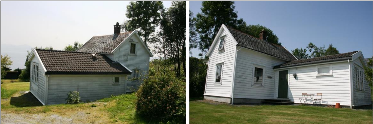
Figur 35 Taket har skifter på den gamle delen og betongtakstein på den «nye» tv. og original bygning mot vest, påbygg mot sør
