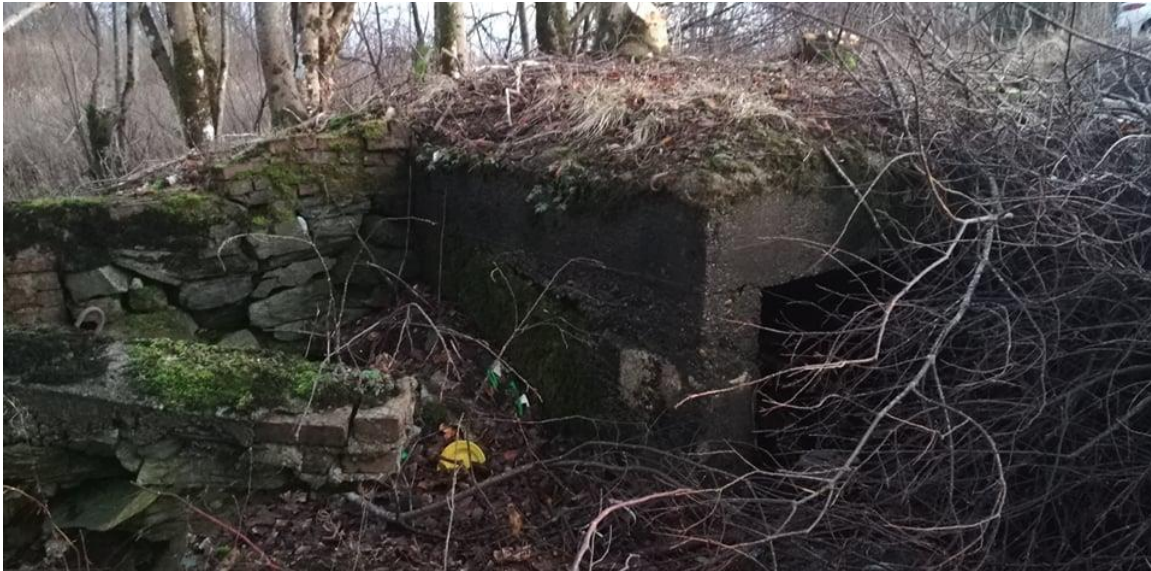
Figur 41: Bunkers, PaK garasje/ammunisjonslager.
