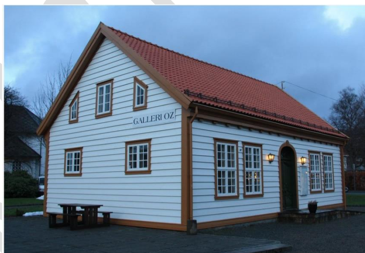
Figur 58: Kommunehuset er seinare flytta to gonger, først til Osøyro i 1884 som kommunehus, frå Molda, og så i 1986 vart huset trilla på jamrøyr til Kyrkjeflaten der det har vert kunstgalleri fram til og med 2014. No er det "Os Frivillighetssentral" som held til i dette fine gamle bygget.
