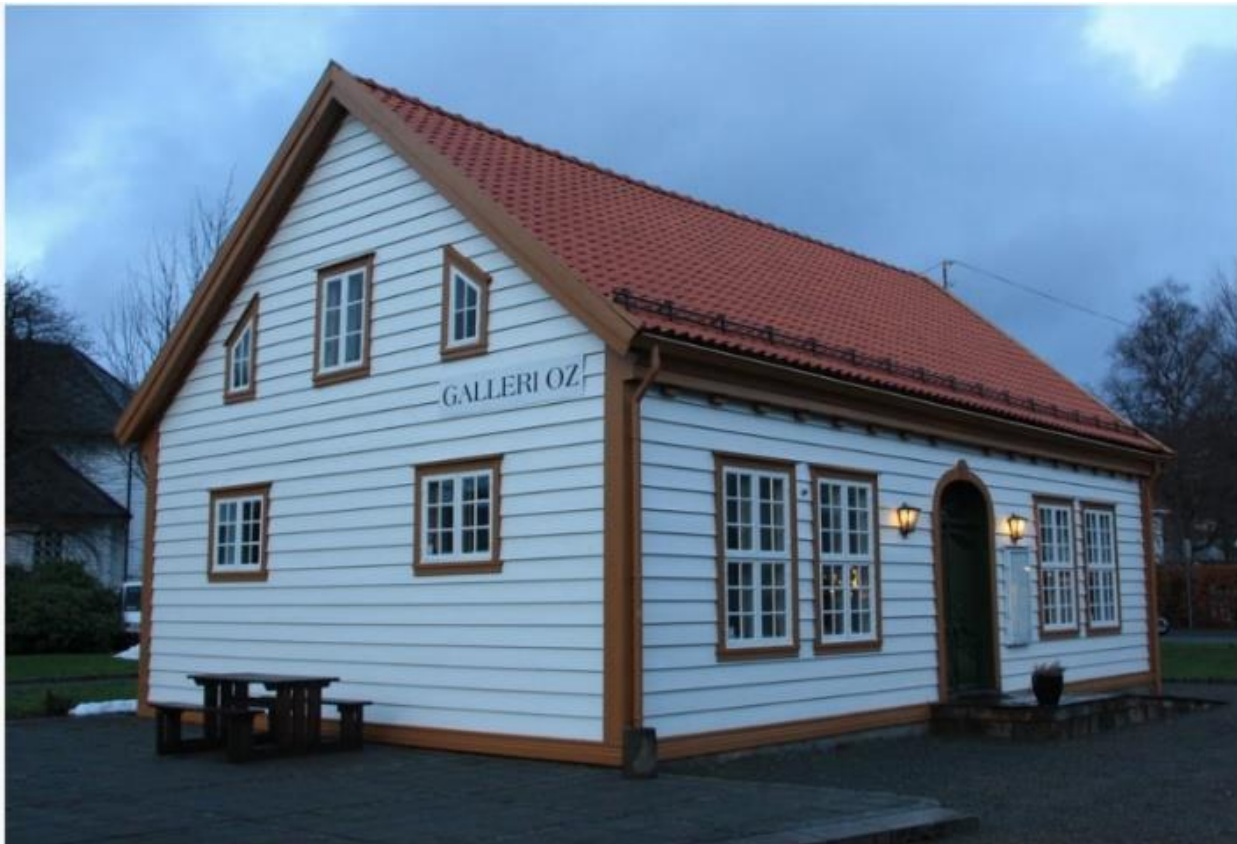
Figur 7: Kommunehuset er seinare flytta to gonger, først til Osøyro i 1884 som kommunehus, frå Molda, og så i 1986 vart huset trilla på jarnrøyr til Kyrkjeflaten der det har vort kunstgalleri fram til og med 2014. No er det "Os Frivilligsentral" som held til i dette fine gamle bygget.
