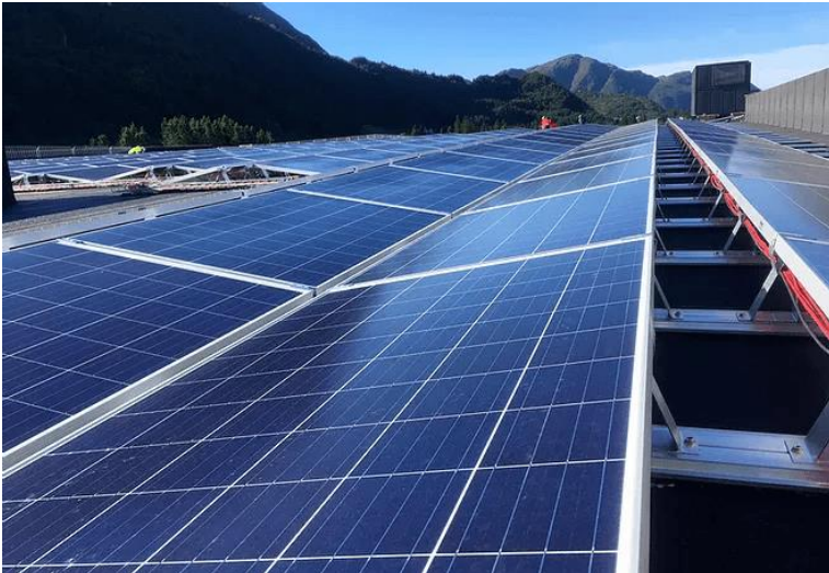
Figur 6-7 - Solcelleinstallasjon på tak, ASKO VEST, Bergen. Kjelde: Fusen.no
