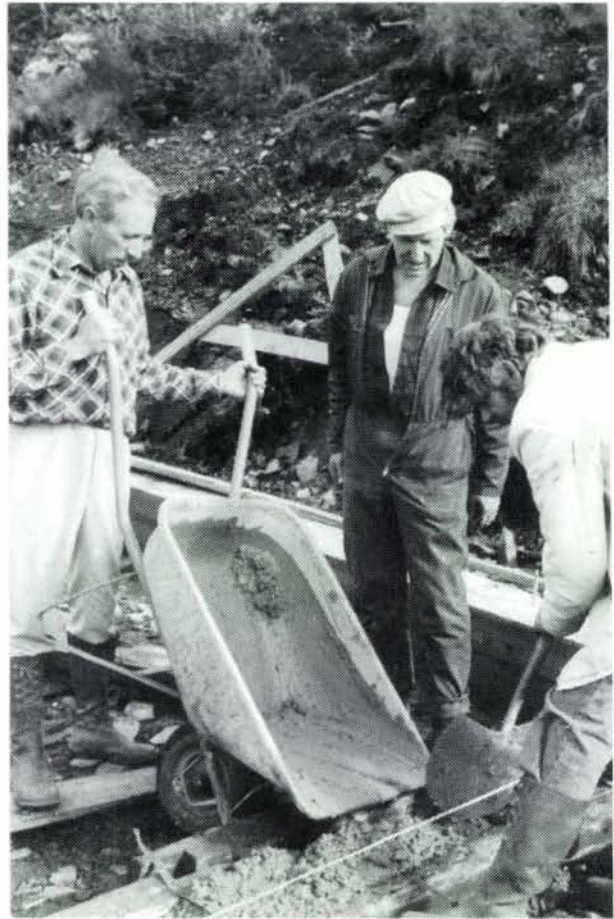
Dugnad: Grunnmuren til hangaren blir støyt 1976. Frå venstre: Asbjørn Nicolaysen, Johannes Heggland, Lars Skorpen. (Foto: Svein Døsen).
