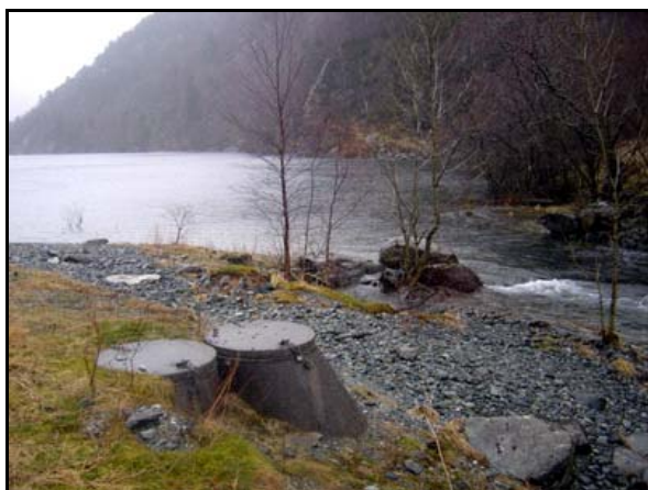
Figur 13. Kummer for vanninntaket ved utløpet av Øvredalsvatnet (til venstre) og for nødvannforsyning fra Lønningdalselven (til høyre).
