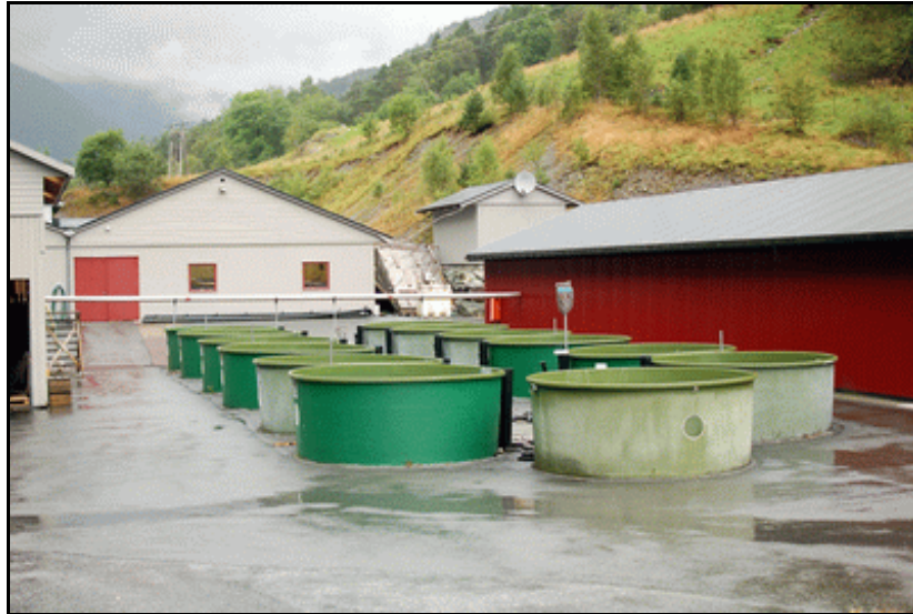
Figur 1. EWOS Innovation AS sitt settefiskanlegg HO 004 i Lønningdal. De to rekkene med små kar skal erstattes av en rad med 8-meters kar under tak.
