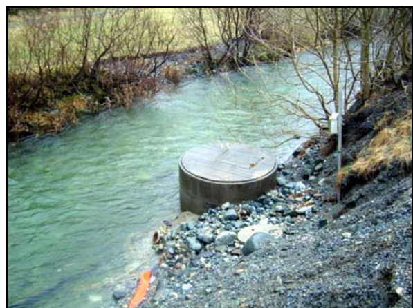
Figur 13. Kummer for vanninntaket ved utløpet av Øvredalsvatnet (til venstre) og for nødvannforsyning fra Lønningdalselven (til høyre).
