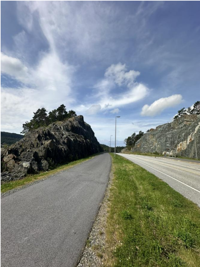
Figur 19: Fylkesveg, gang og sykkelveg og busshaldeplass
