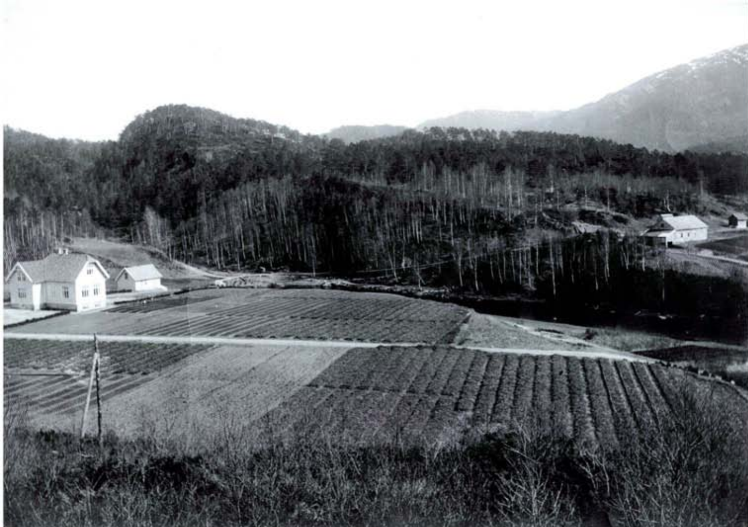
Eikhauggarden t.v. etter at undervisningsfløyen er påbygd og forsøksstykket framfor er stelt i stand.
