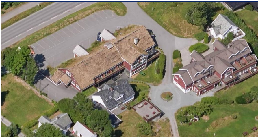
Figur 53 Skråfoto som viser dagens bygningar på eigedomen
